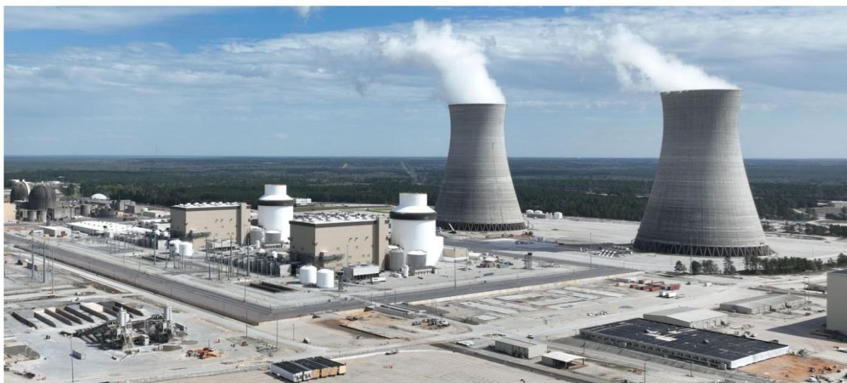
Figuur 3-5: Voorbeeld bedrijfsfase; Vogtle (bron: Westinghouse Nuclear, 2024). Noot: Deze Westinghouse maakt gebruik van koeltorens. Het uitgangspunt voor de nieuwe kerncentrales in Nederland is dat er gekoeld wordt met oppervlaktewater, waardoor er een pomphuis voor in de plaats komt.
