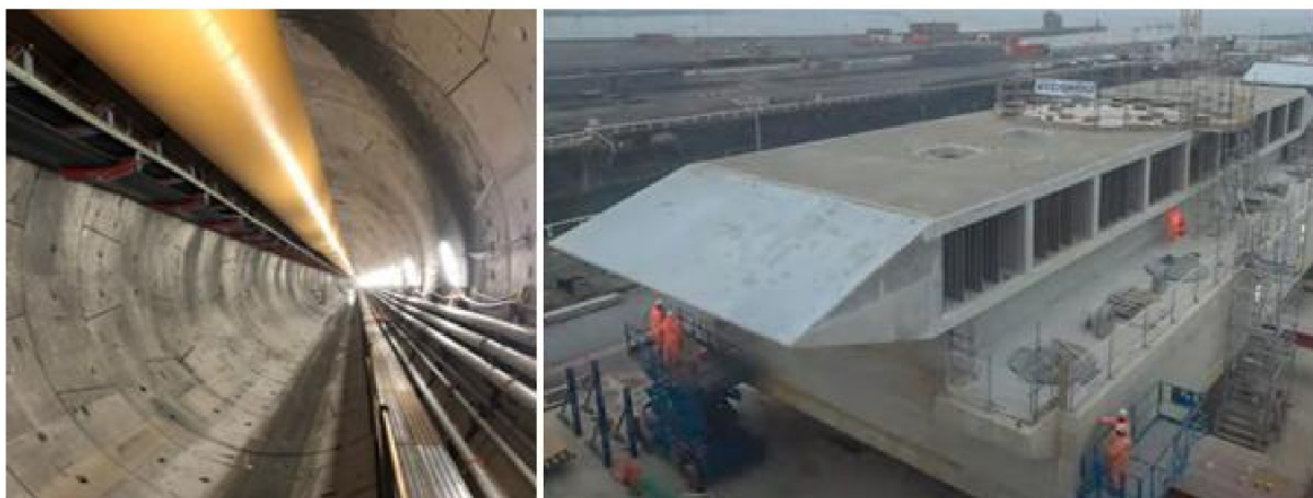
Figuur 5-11: Voorbeeld van een tunnelbuis voor koelwater (links) en het bouwwerk voor de tunnelmond (44 x 16 x 10 m.) van de inlaat (rechts) van Hinkley Point C. Deze worden locatiespecifiek ontworpen op basis van o.a. bodemgesteldheid, stroming en diepte.
